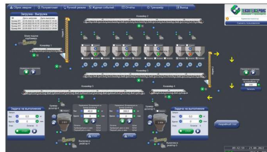
Автоматизированное дозирование и перекачка карбамида
